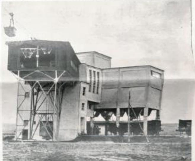
→ Das Langauer Kohlebergwerk ist mit den modernsten Anlagen ausgestattet. Unser Bild zeigt, wie die Kohle in Seilbahn-Häuten von der über 2 km entfernten Grube zum Werkshof transportiert wird. Hier erfolgt dann die Sortierung der Kohle und der Weitertransport nach Wien.
