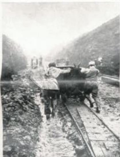
↑ Die Braunkohle wird auch in Langau im Tagebau gefördert. Beim Graben nach Schichten war von besonderer Wichtigkeit Braunkohle/Konkussion gestalten. Die Kohle wird mit der Hand gebrochen und in Handen zu einem Sammelstapel gefüllt, wo sie von einer Seilbahn zu Brech- und Sortieranlagen weiterbefördert wird.
