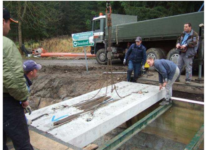
Über die Wintermonate werden unsere Außendienstmitarbeiter ein Geländer fertigen und montieren. Die Brücke selbst wird nach einer entsprechenden Aushärtungsphase ca. Mitte Dezember wieder befahrbar sein und hat zukünftig eine Belastbarkeit von 25 Tonnen!
